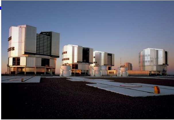
Abris ventilés, refroidis avec très grandes ouvertures
